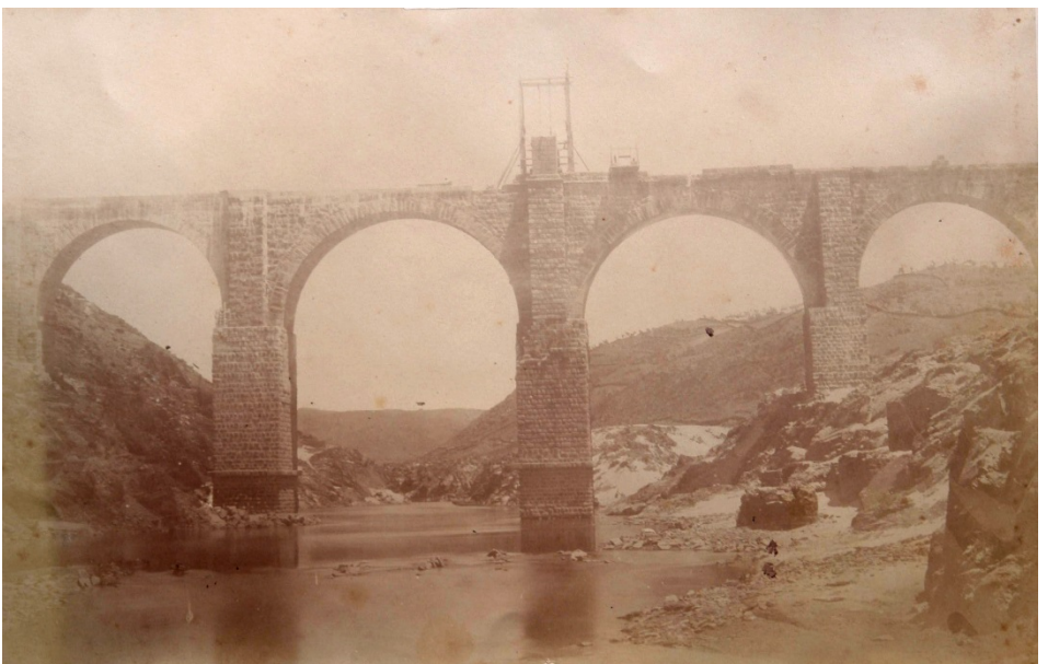
El puente durante las obras de reconstrucción del arco triunfal. Fotografía de Charles Clifford (1860)
